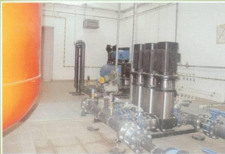
Urządzenia technologiczne wewnątrz Stacji, u góry - zestaw pomp II stopnia, poniżej dmuchawa powietrza oraz szafa sterująca, 6.01.2006
