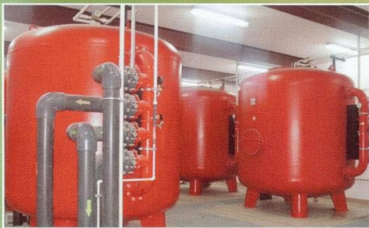
Urządzenia technologiczne wewnątrz Stacji, filtry ciśnieniowe, 6.01.2006
