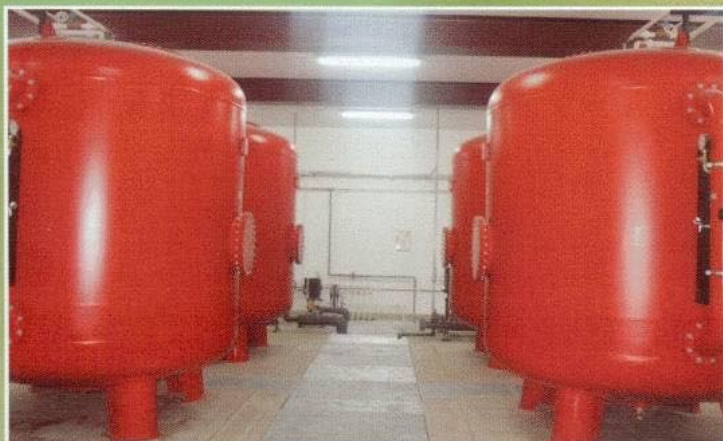
Urządzenia technologiczne wewnątrz Stacji, filtry ciśnieniowe, 6.01.2006
