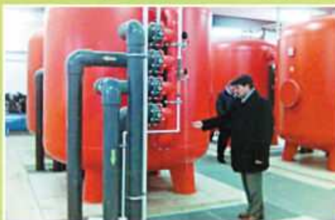
Urządzenia technologiczne wewnątrz Stacji, filtry ciśnieniowe
