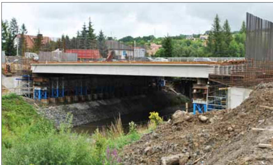
Budowa czteropasmowego mostu na Strugu w Tyczynie
