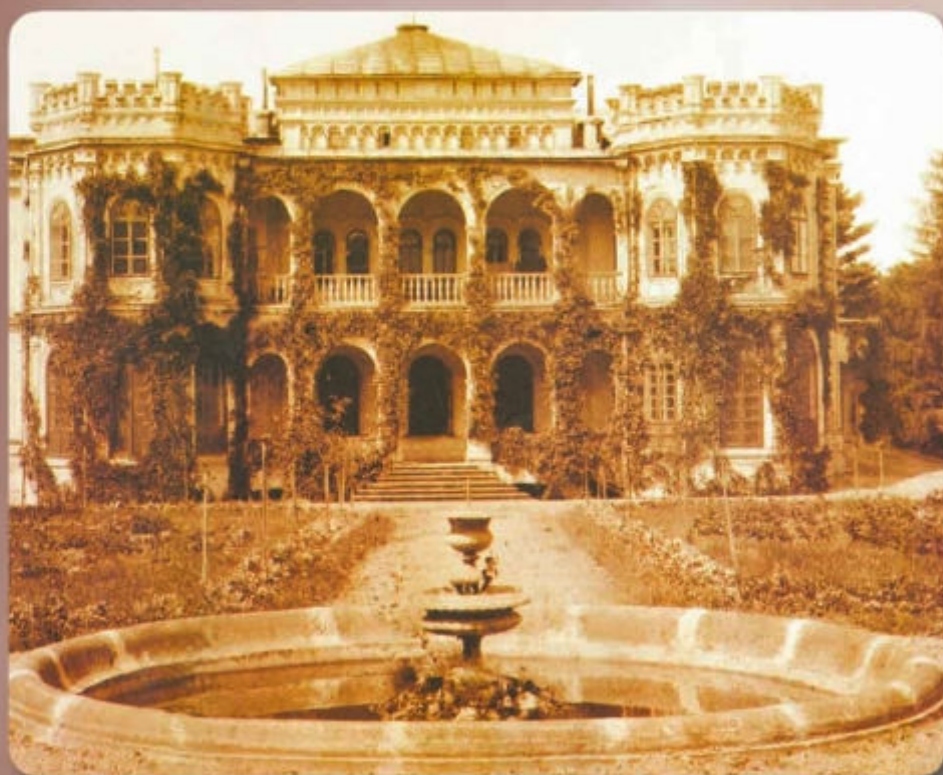
Pałac Wodzickich w Tyczynie. Widok od strony południowej. Stan z początku XX w.
